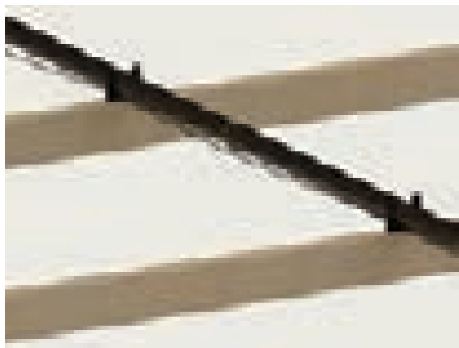
Allawayn putkikiinnike kannakoi putket. Putkikiinnikkeessä on huomioitu myös pienjännitejohtimien kulku putkiston vierellä.
